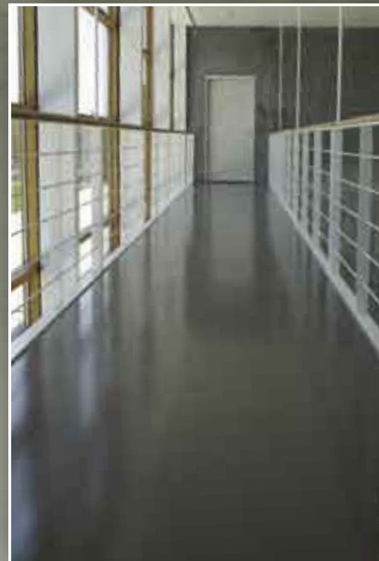
Politihøyskolen, København, Danmark. Konstruksjonen er et flytende lydgvulv som er spesifisert ut fra maxits retningslinjer og beregningsprogram for trinnlydsreduksjon. maxit Floor 4610 DuroTop Svart, 4600 DuroBase, porefyller og 4793 gulvpolish matt.
