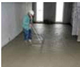
Efter udpumpning og fordeling af afretningsmassen afrettes arealet med en svappestang.
